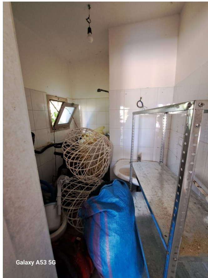
FOTO 15 Servizio ig. (centr. Idrica) del garage
