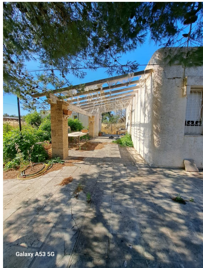
FOTO 4 Abitazione Lato ovest (in corrispondenza del BCNC sub 3)
