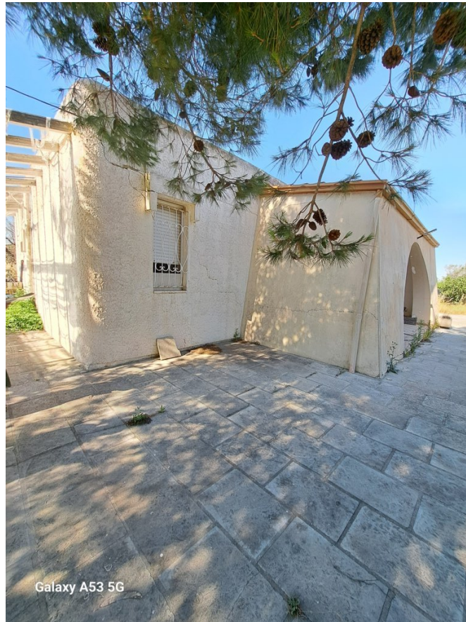
FOTO 5 Abitazione lato sud-ovest
