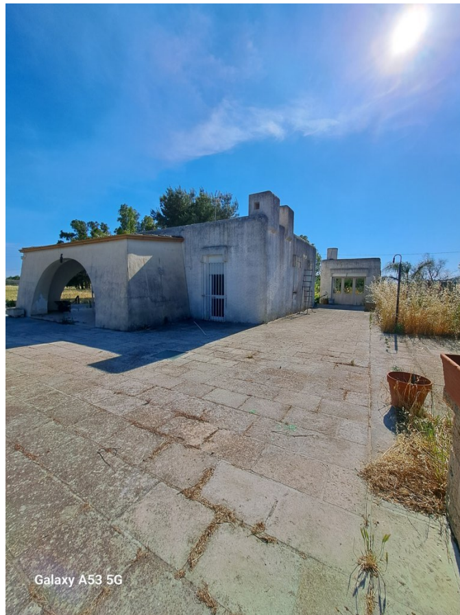
FOTO 3 Abitazione e garage su zona pavimentata – lato nord
